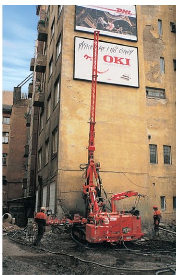
Vrtná souprava pro mikropiloty a tryskovou injektáž
